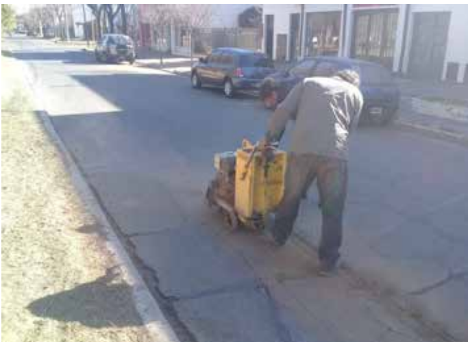
Aserradora de pavimento
